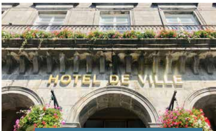
Fin des travaux de mise aux normes de la mairie
