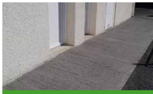
Installation d'une rampe d'accès pour les Personnes à Mobilité Réduite (PMR) aux vestiaires du stade
