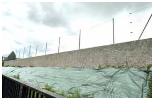
Mur de soutènement au skate-park
