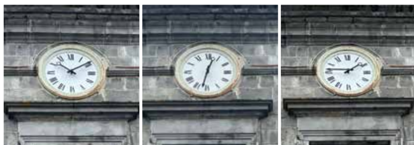
Réparation de l'horloge du bâtiment de l'hôtel de ville
